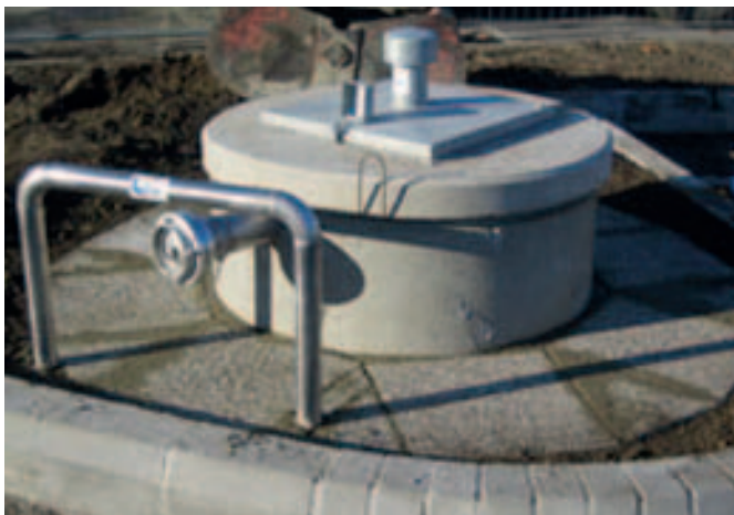
Schaubild Löschwasserbrunnen
